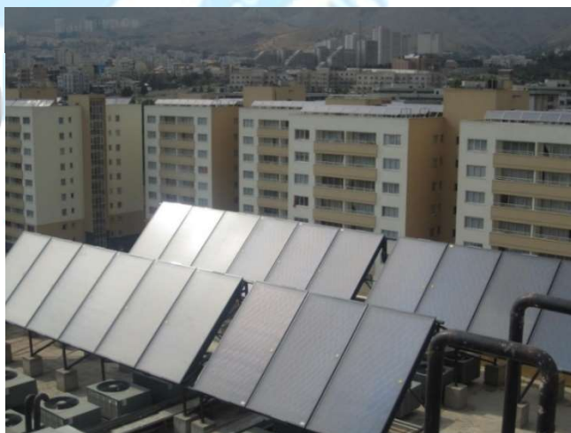
شکل ۴- سیستم مرکزی - متصل به موتورخانه حرارت مرکزی (تهران - سنول) ظرفیت ۱۶۰۰۰ لیتر در روز
