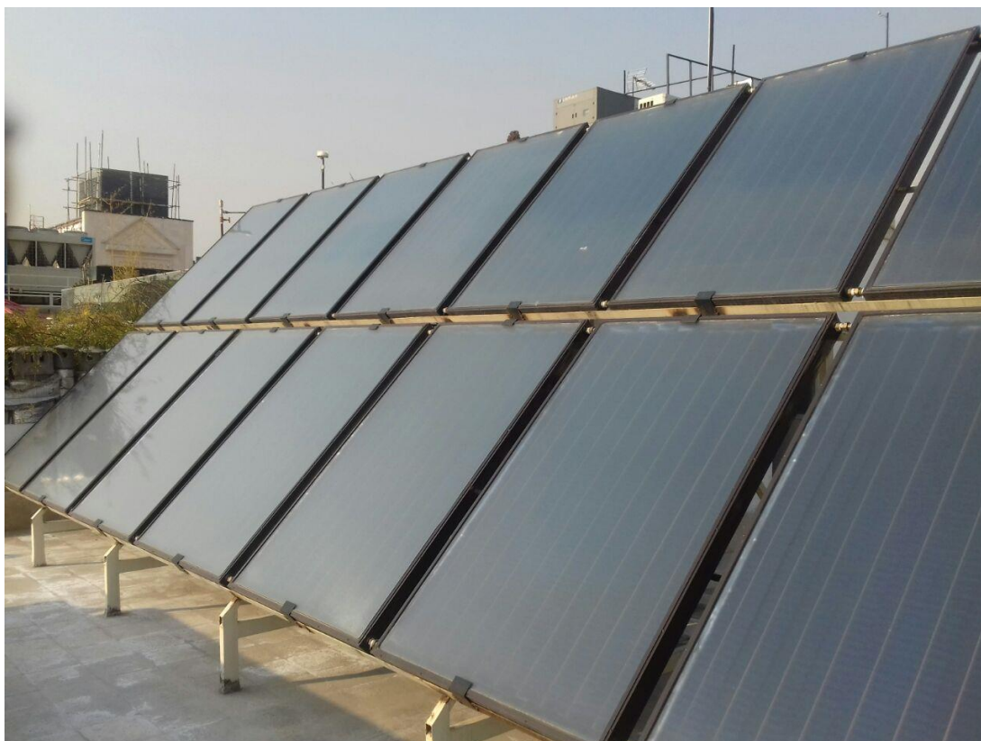
شکل ۹- طراحی سازه دو طبقه جهت فضاهای محدود در پشت بام
