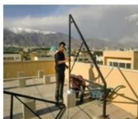
مرحله اول (نصب استراکچر)
