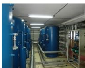
مرحله ۳- نصب تانک مجموعه پمپ و عایق کاری مجموعه خورشیدی
