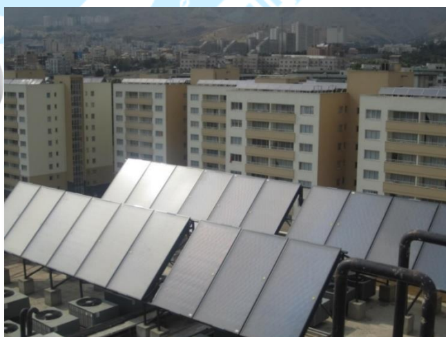
شکل ۴- سیستم مرکزی - متصل به موتورخانه حرارت مرکزی (تهران - سئول) ظرفیت ۱۶۰۰۰ لیتر در روز
