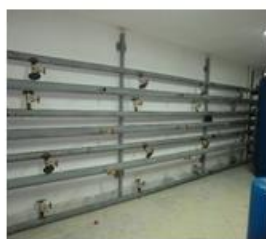
مرحله دوم- لوله کشی و تست سیرکولاسیون و عایق بندی لوله ها
