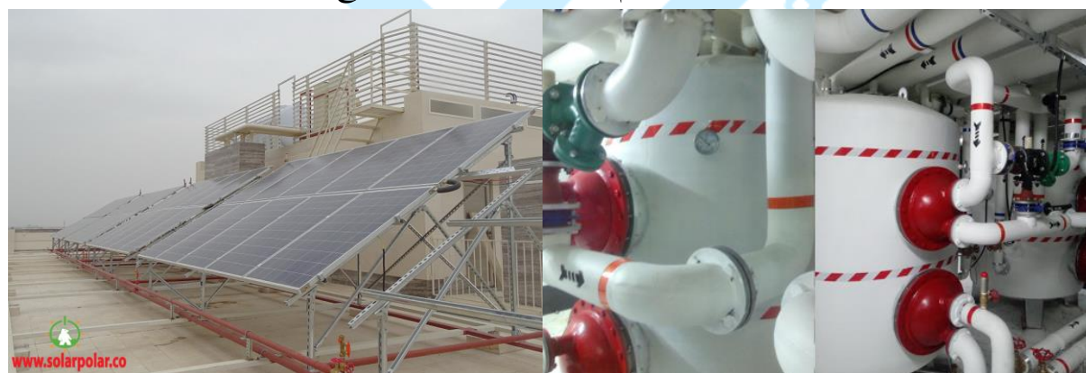
شکل ۱۹- مجتمع رزلند اصفهان، ۱۱ کیلووات تولید برق و ۶۰۰۰ لیتر آب گرم
