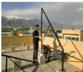
مرحله اول (نصب استراکچر)
